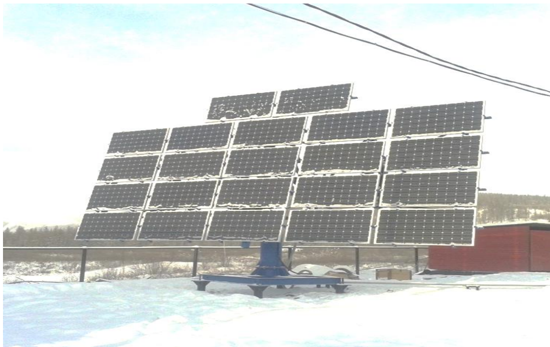
Рисунок 14. Солнечный трекер мощностью 10 кВт в поселке Ючюгей Оймяконского района
